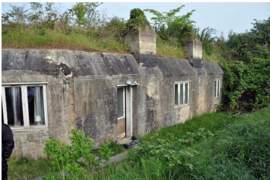
Bunkeren, som den ser ud i 2011 efter at være ombygget til sommerhus med vinduer og døre eftermonteret. Foto: Anders Knudsen i www.folketidende.dk
