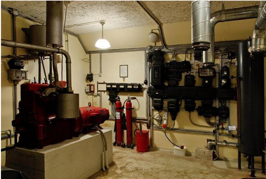
Eltavle og nødstrømsforsyning. Foto: Ejendomsmægler John Ole Hansen 2013.
